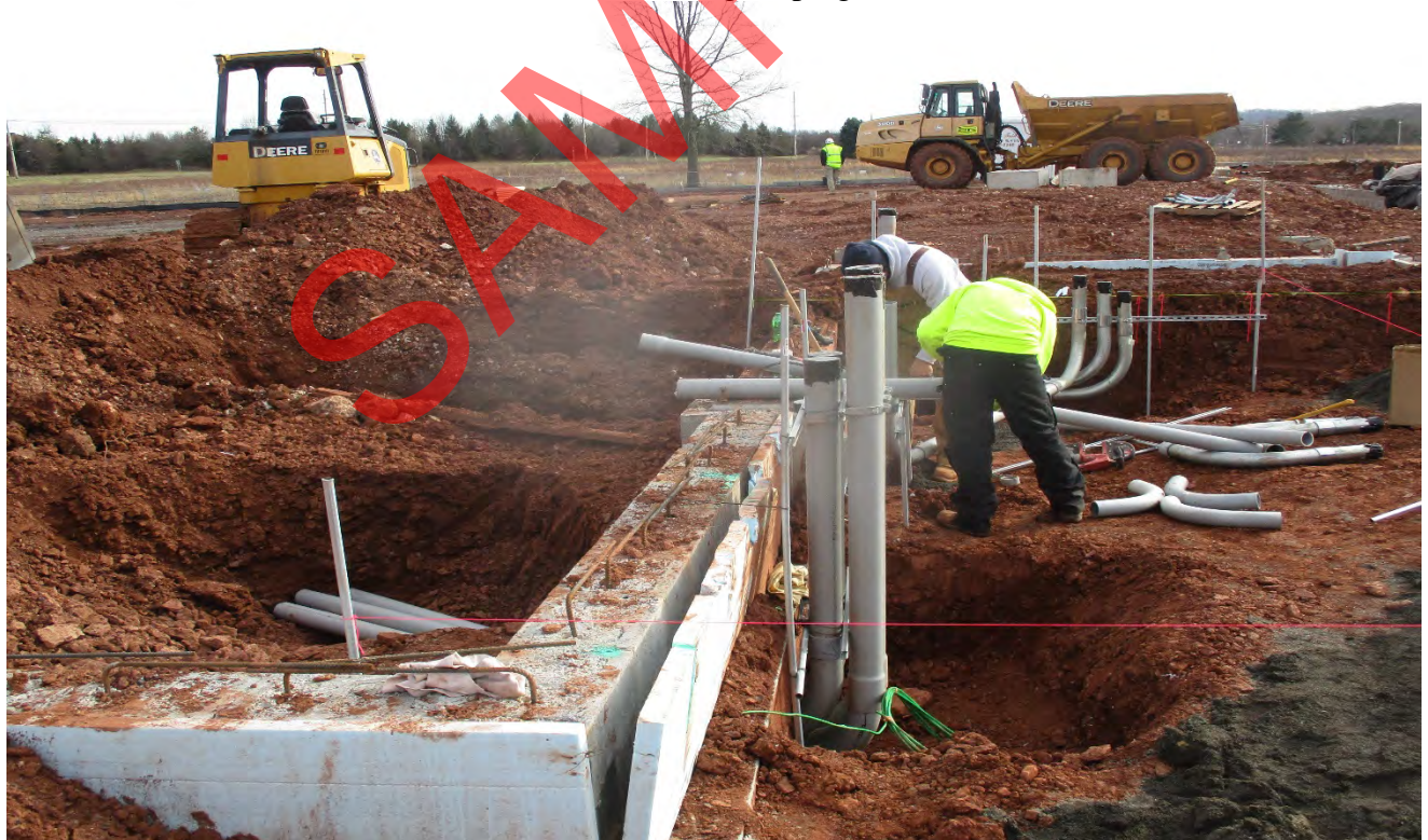
Electrical Room Service Conduit
